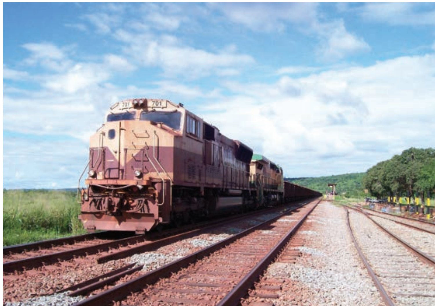
• Estrada de Ferro Carajás, da Vale, cuja construção gerou compensações financeiras para os povos indígenas no Maranhão. Foto: Fernando Cunha
